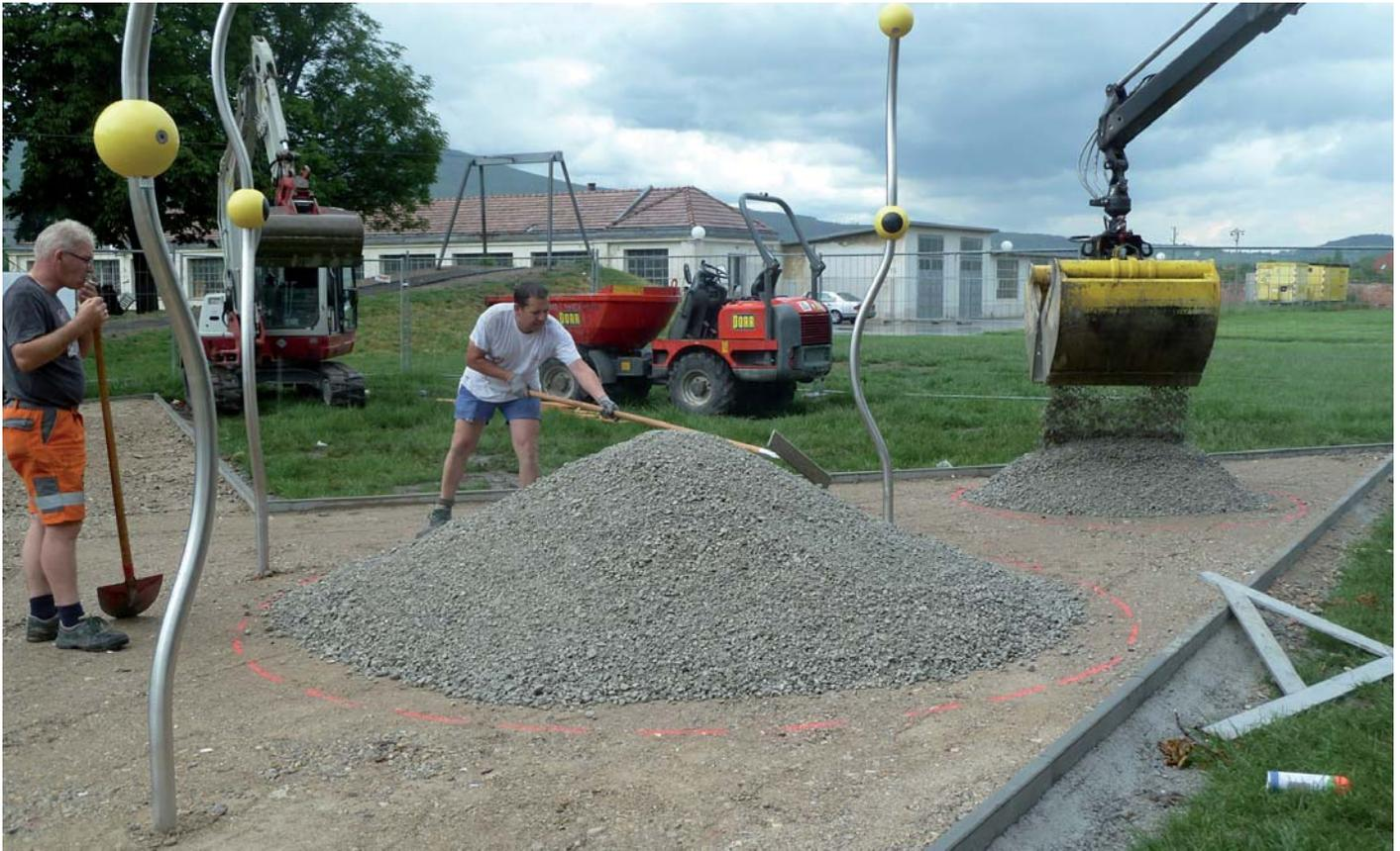
Abb. Herstellung Bodenmodellierung mit Ortbeton 24.5.2016; 13:26
