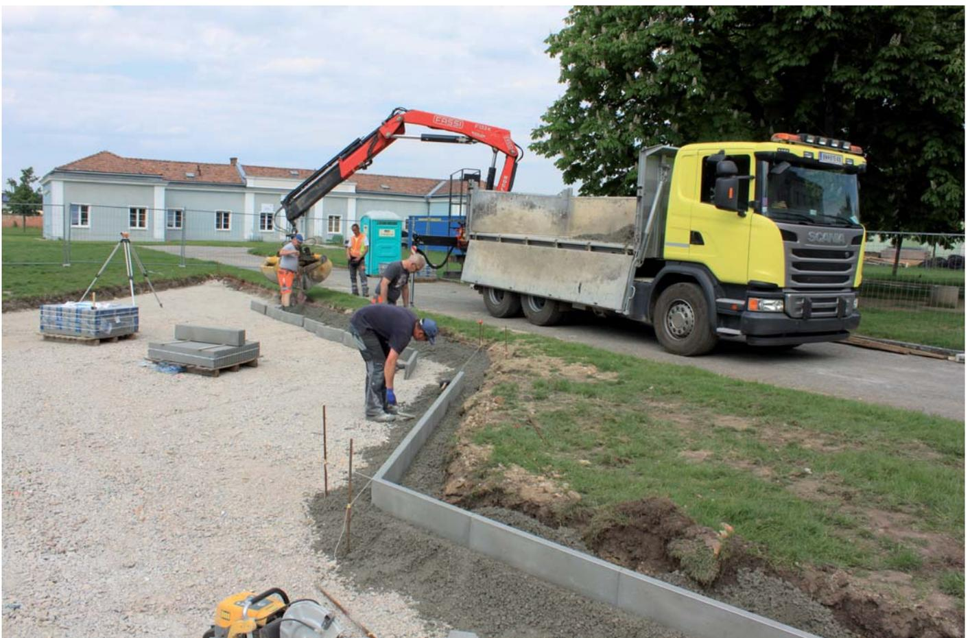
Abb. Einbau Betonrandsteine 18.5.2016; 14:29
