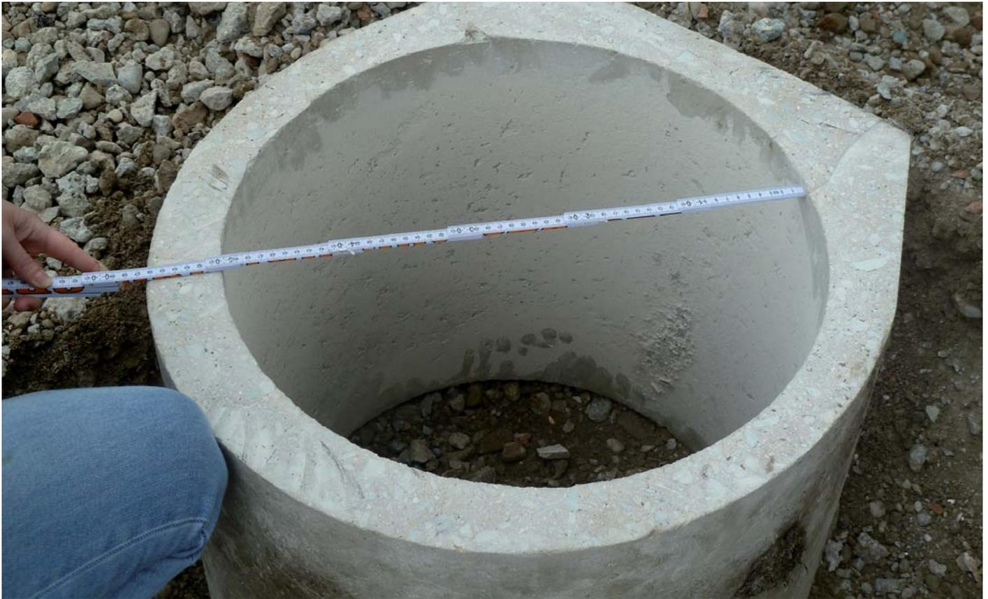
Abb. Formrohre für Fundamente „HBH“ D = 50cm; T = 70cm 24.5.2016; 11:45
