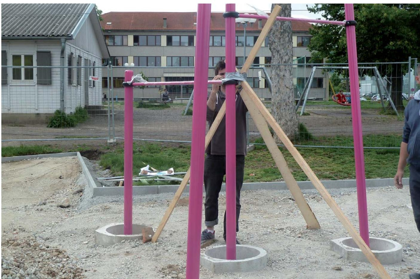
Abb. Einbau HBH Stangengeräte 24.5.2016; 14:44
