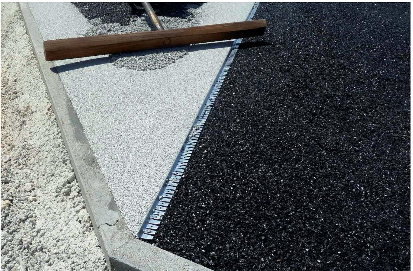
Abb. Deckschicht Fallschutzbelag grau Dicke = 3cm (schwarz) + 1cm (grau) 07.6.2016; 13:13
