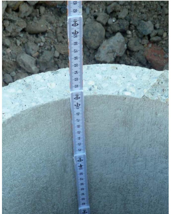
Abb. Fundament „Euroflex Halbkugel“ T = 50cm 02.6.2016; 07:55
