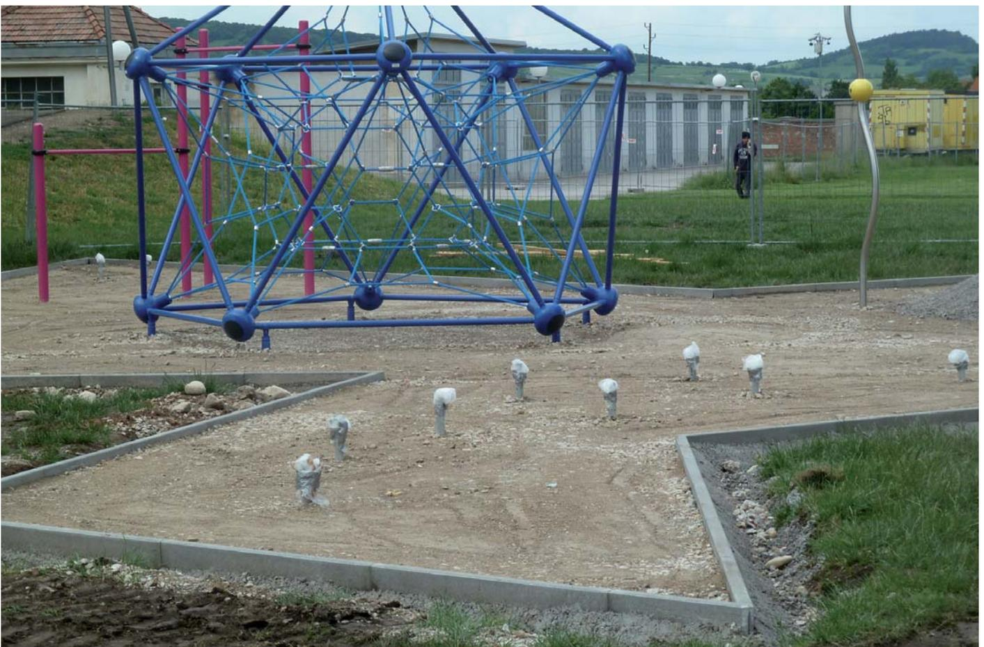
Abb. Schutzabdeckung Bodenanker 02.6.2016; 15:23
