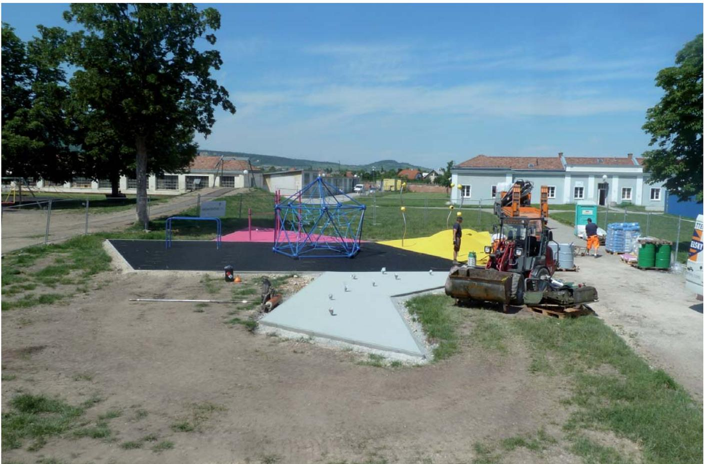
Abb. Fallschutzbelag Deckschicht M, Y, grau; Dicke 1cm OK = 0.0 08.6.2016; 14:38
