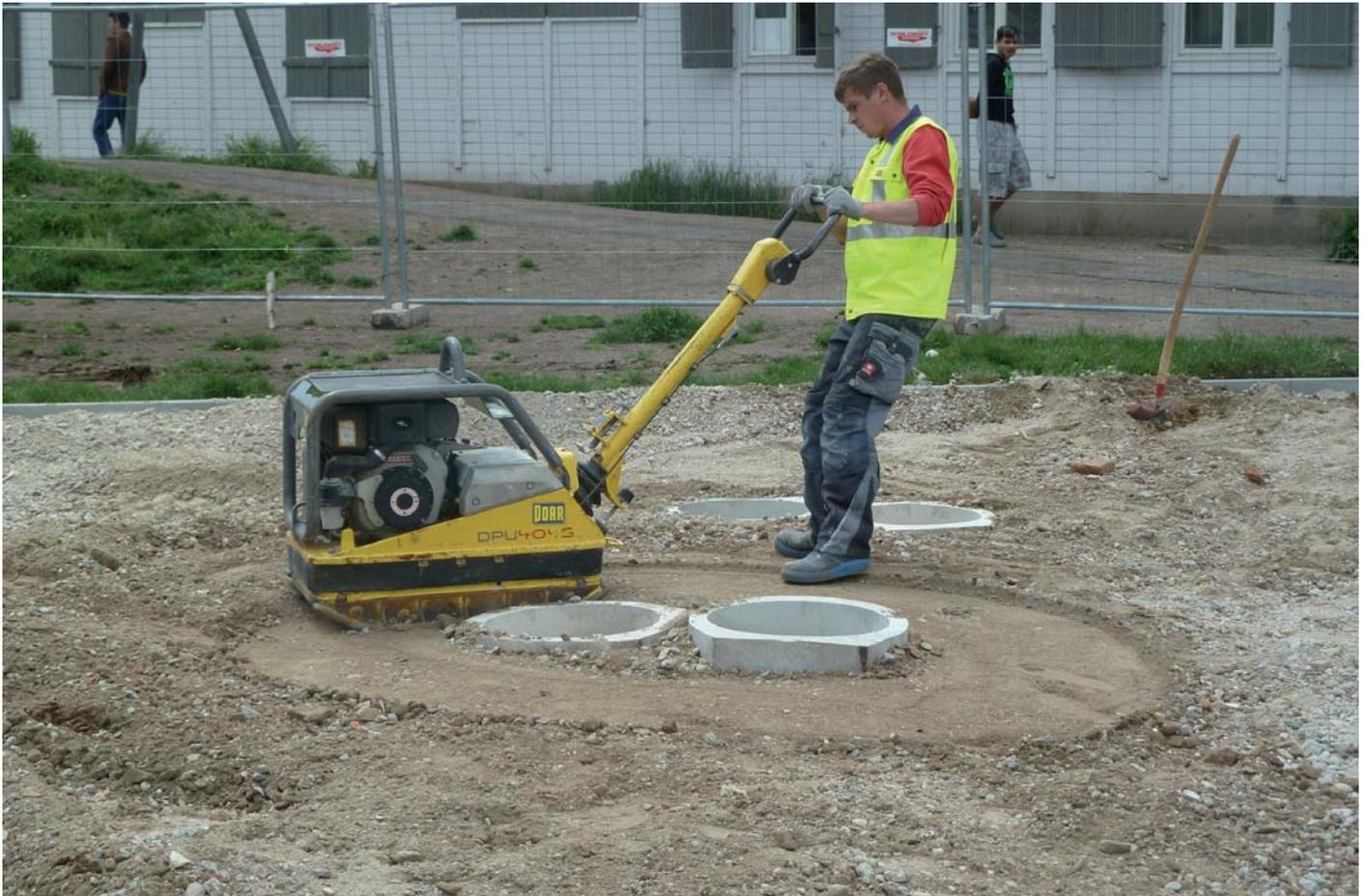
Abb. **Bodenverdichtung** 24.5.2016; 14:14
