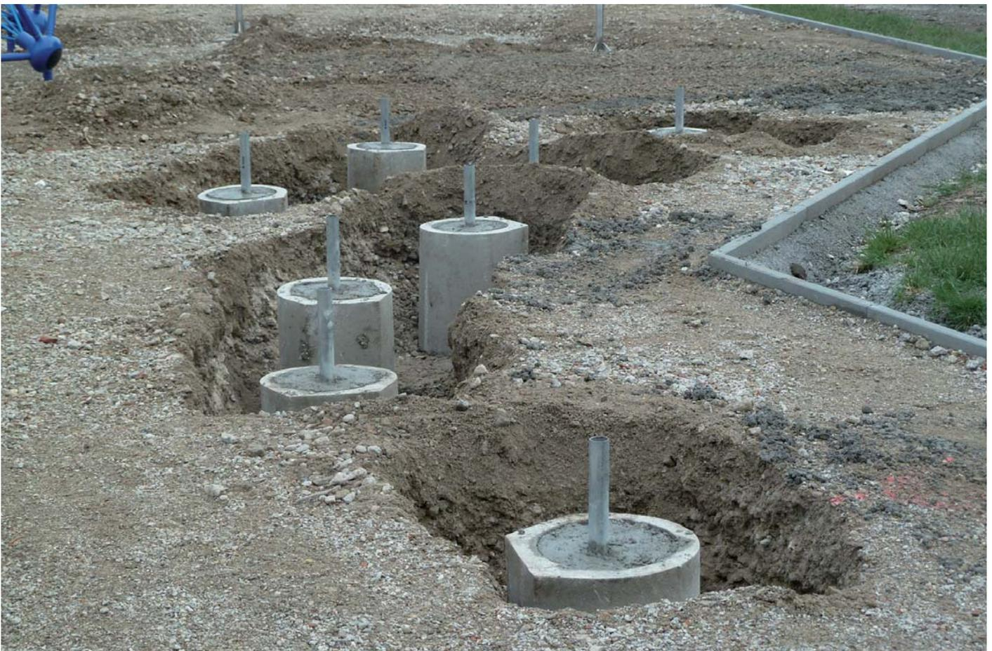
Abb. Punktfundamente „Euroflex Halbkugeln“ D = 30cm, T = 50cm 02.6.2016; 09:20
