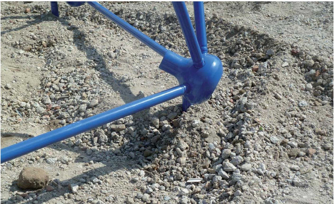
Abb. **Einschüttung Fundamentplatten „Roplay Vario“** 24.5.2016; 15:42
