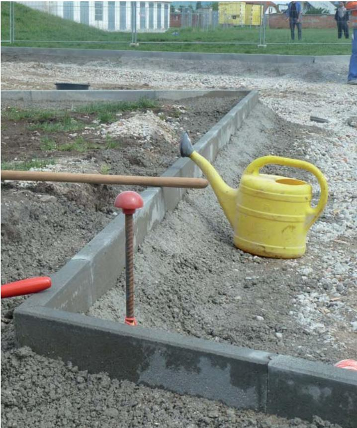
Abb. Versetzen Betonrandsteine 20.5.2016; 10:31
