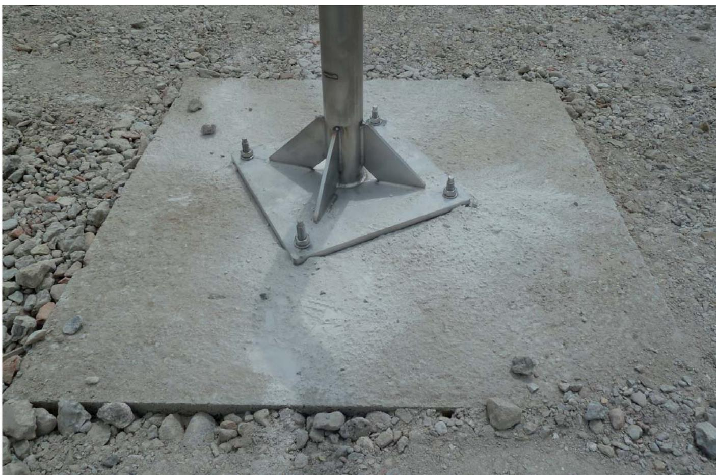
Abb. Befestigung „Spirelli“ auf Punktfundament 24.5.2016; 13:45
