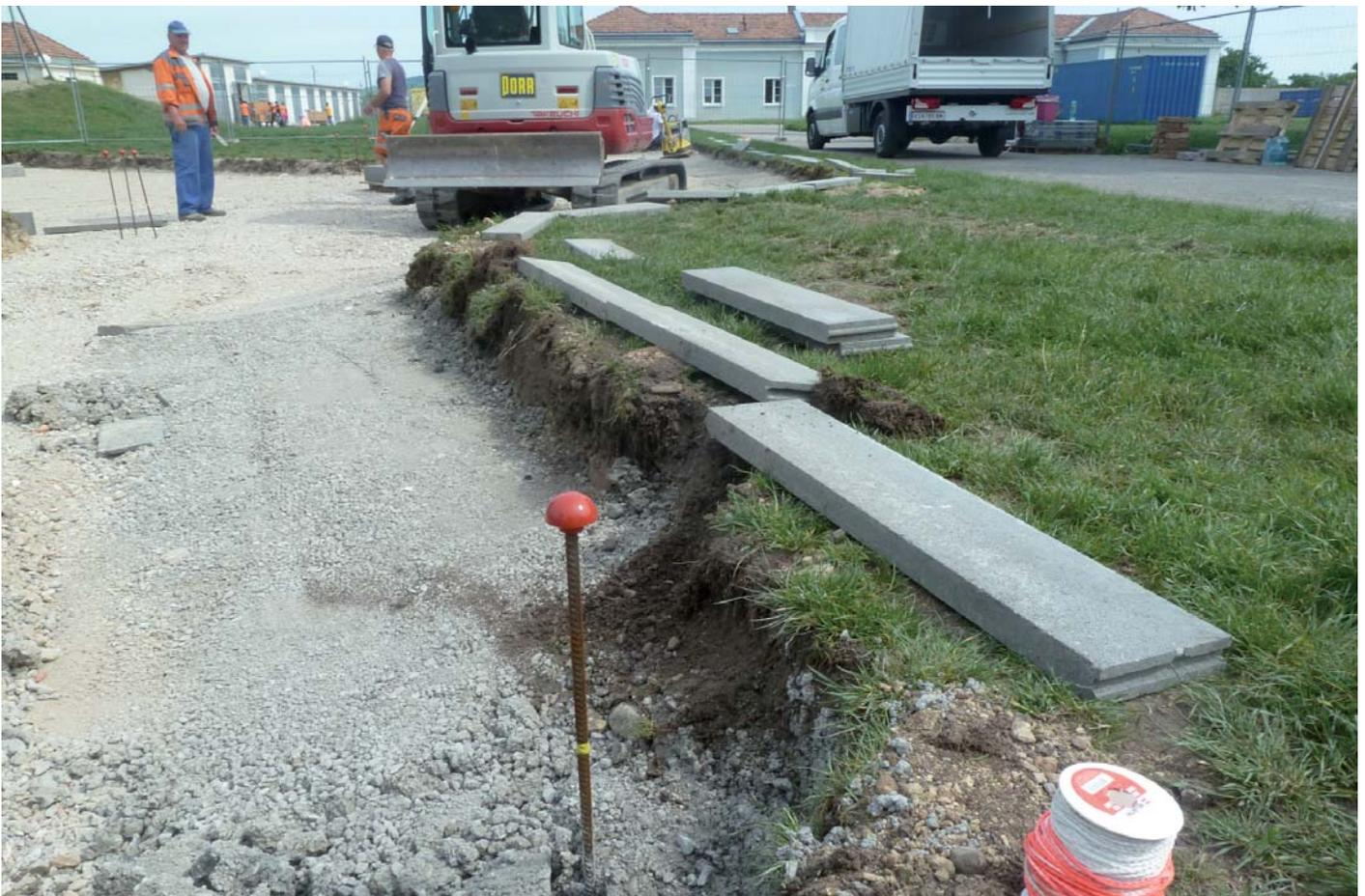
Abb. Niveau Betonrandsteineinfassung NEU: OK = höchster Geländepunkt + 2cm 19.5.2016; 10:17
