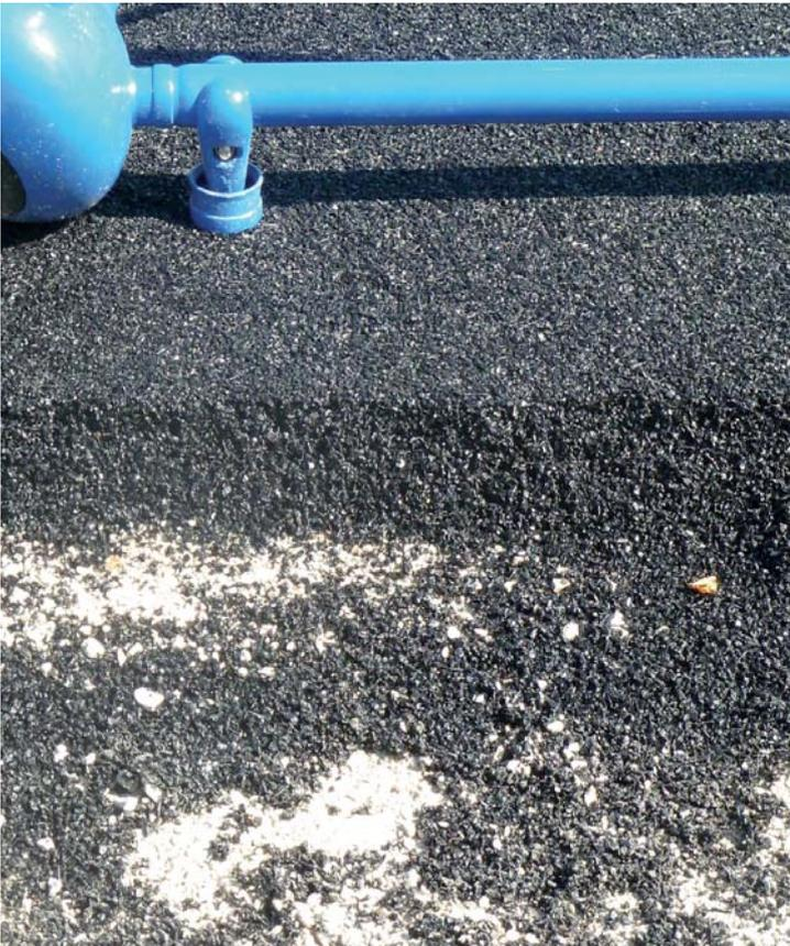
Abb. Fallschutzbelag Dicke 7cm 07.6.2016; 09:14
