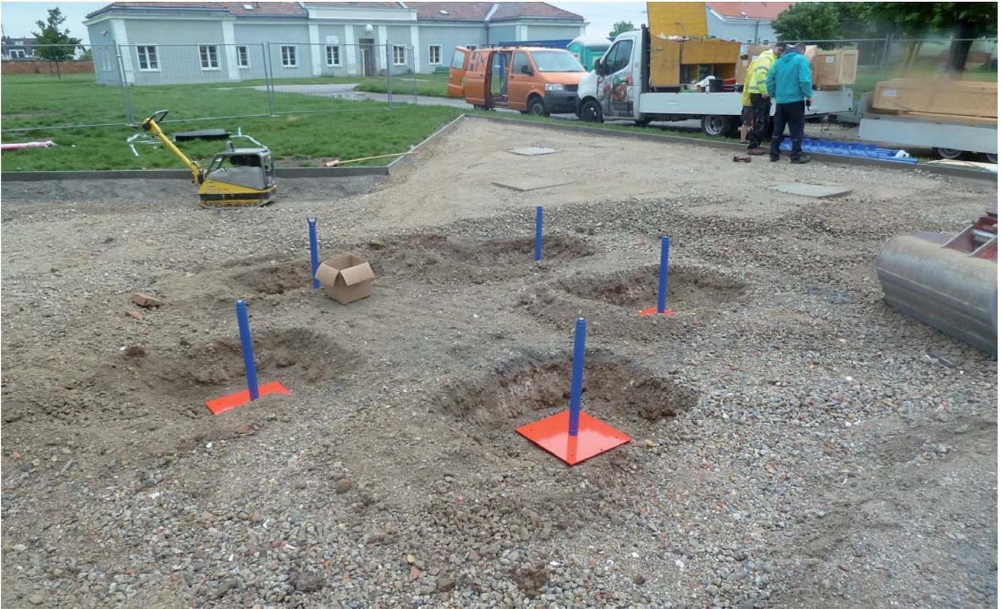
Abb. Fundamentplatten „Vario“ 24.5.2016; 10:14
