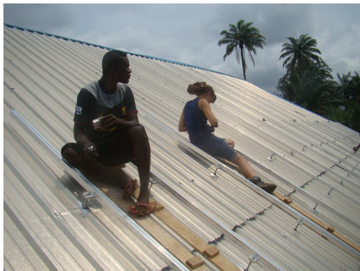
Befestigung der Modulhalter durch das 0,5mm –starke- Aluminiumdach
