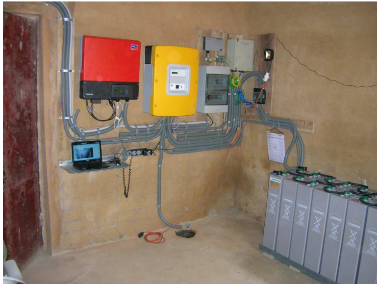
Akkuraum nach Abschluss der Installationsarbeiten
