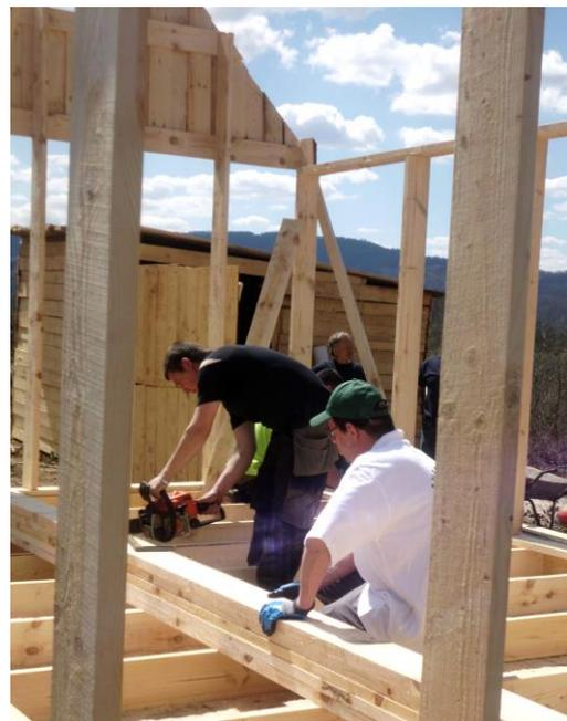
Die Arbeit geht gut voran und bis am Abend stehen die ersten Dachbalken. Die Seitenwände sind außen schon vernagelt und das Fundament für die Nasszelle ist vorbereitet.
