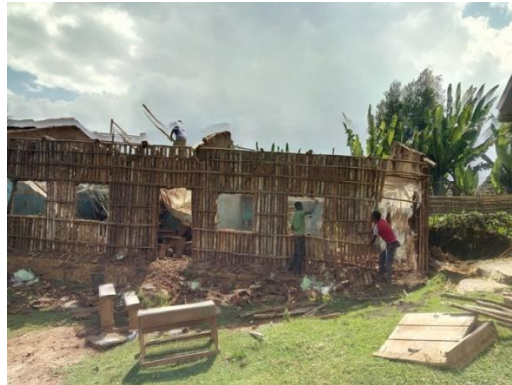
Altes Schulgebäude beim Abriss
